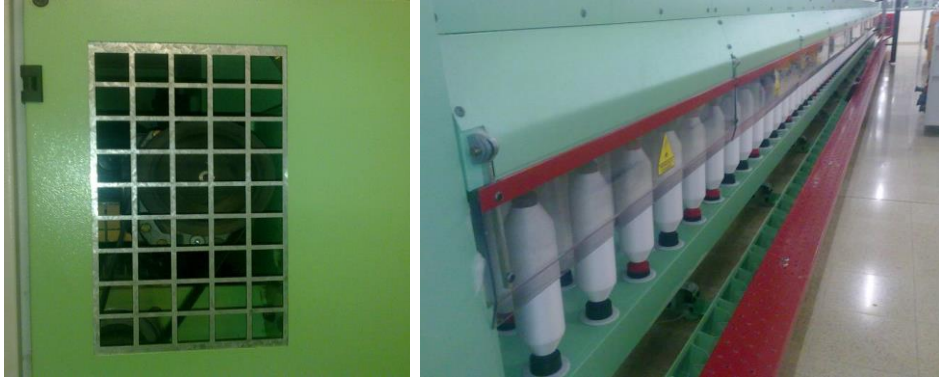
Şekil 3. Uygun şekilde korumaya alınmış kayış-kasnak sistemi/ Şekil 4. Fital makinasının yüksek hızla dönen parçalarına karşı koruma sağlayan şeffaf siperlik koruyucu
