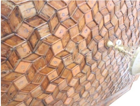
Foto. 8. Konyalıođlu Evi, Restorasyon Sonrası 1. Kat Ahşap Tavan. (Murat Dađdelen)
